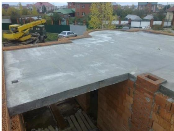
Рис.1. Монолитное перекрытие
