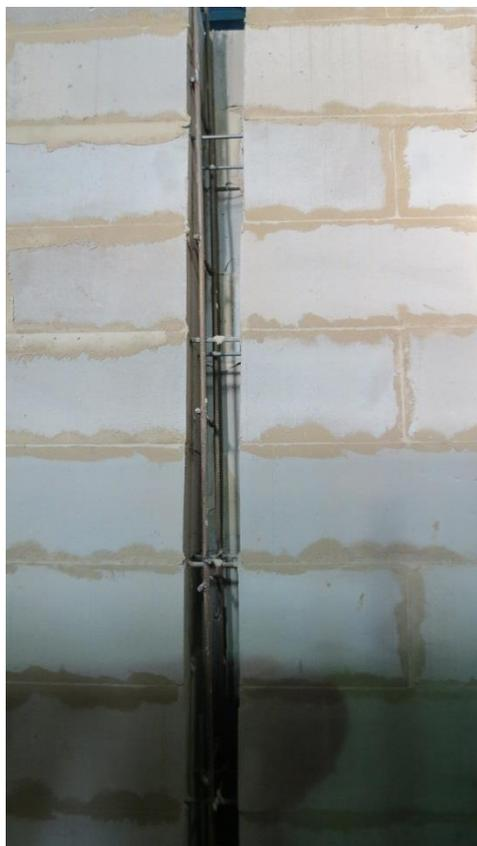
Рис. 3. Монолитный железобетонный сердечник
