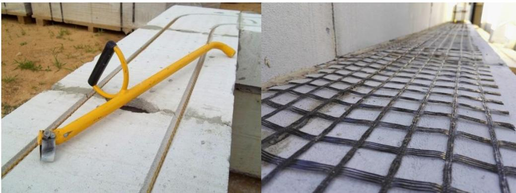
Рис. 1. Горизонтальное армирование кладки:
