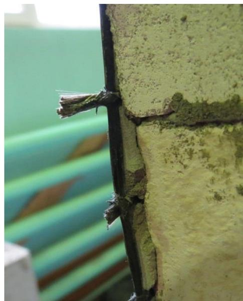
Рис. 2. Вертикальное армирование композитными сетками
