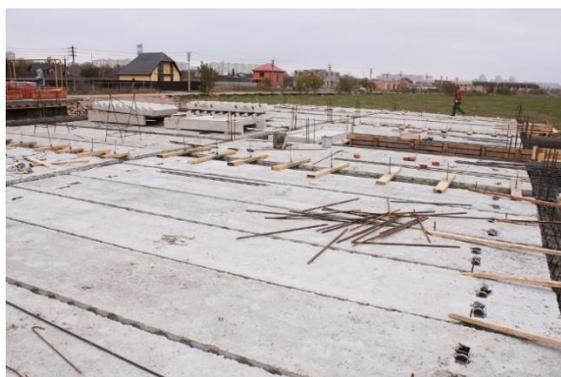
Рис. 2. Сборное железобетонное перекрытие
