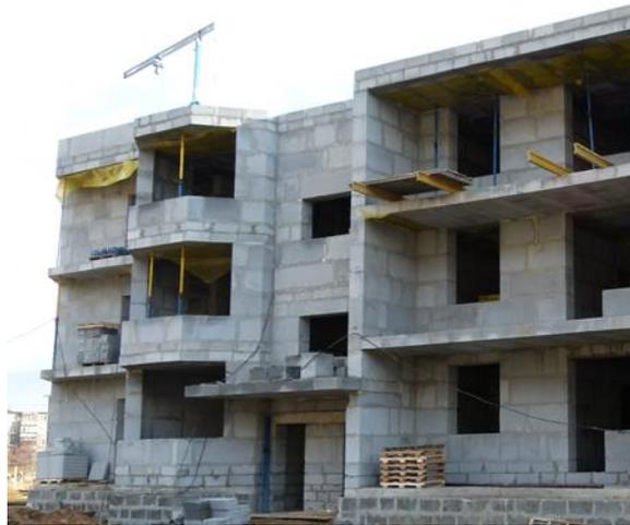
Рис. 1. Применение укрупненных твинблоков при строительстве трехэтажного здания в п. Рефтинский
