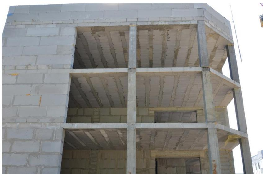
Рис. 4. Применение твинблоков для возведения стен и сборно-монолитных перекрытий
