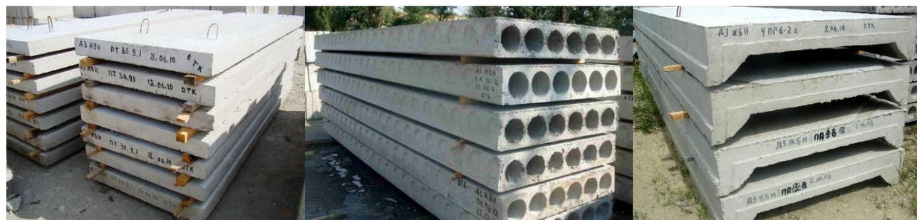
Рис. 3. Наиболее распространенные типы сборных плит: полнотелые, пустотелые и ребристые
