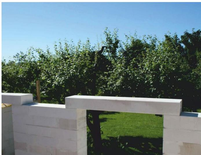
Рис. 4. Перемычка армированная
