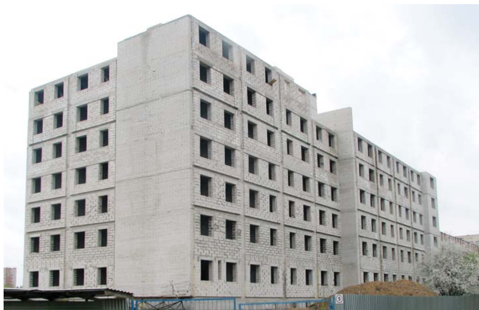
Строящееся общежитие университета
