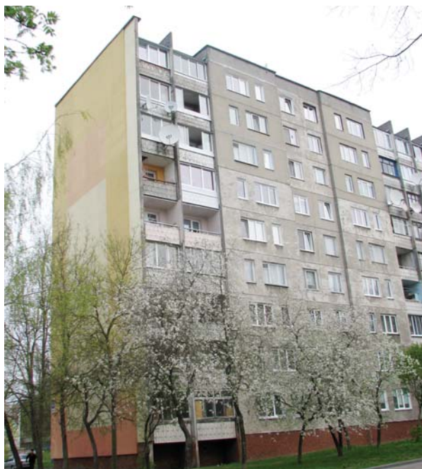
Крупнопанельный дом-гибрид с наружными газосиликатными панелями
