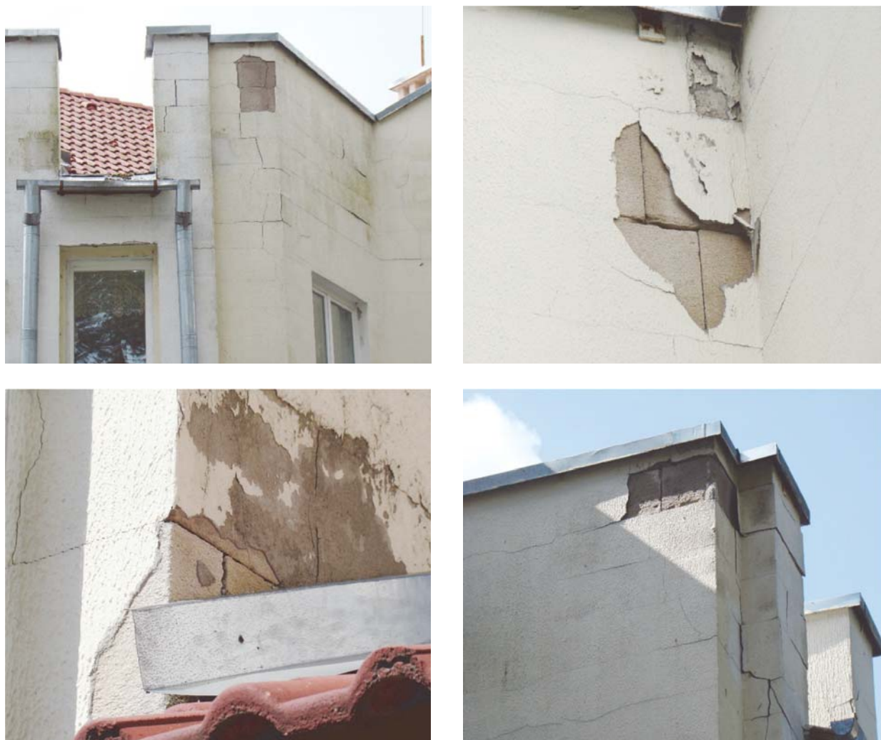
Рис. 3. Фрагменты стеновых ограждающих конструкций с различными видами разрушений, д. Чисть
