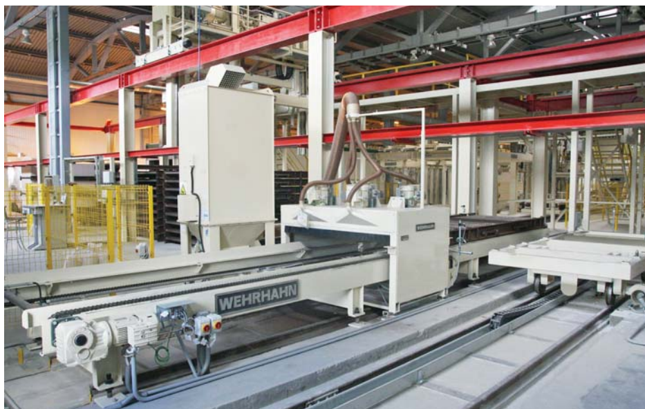
Рис. 3. Установка чистки автоклавных решеток
