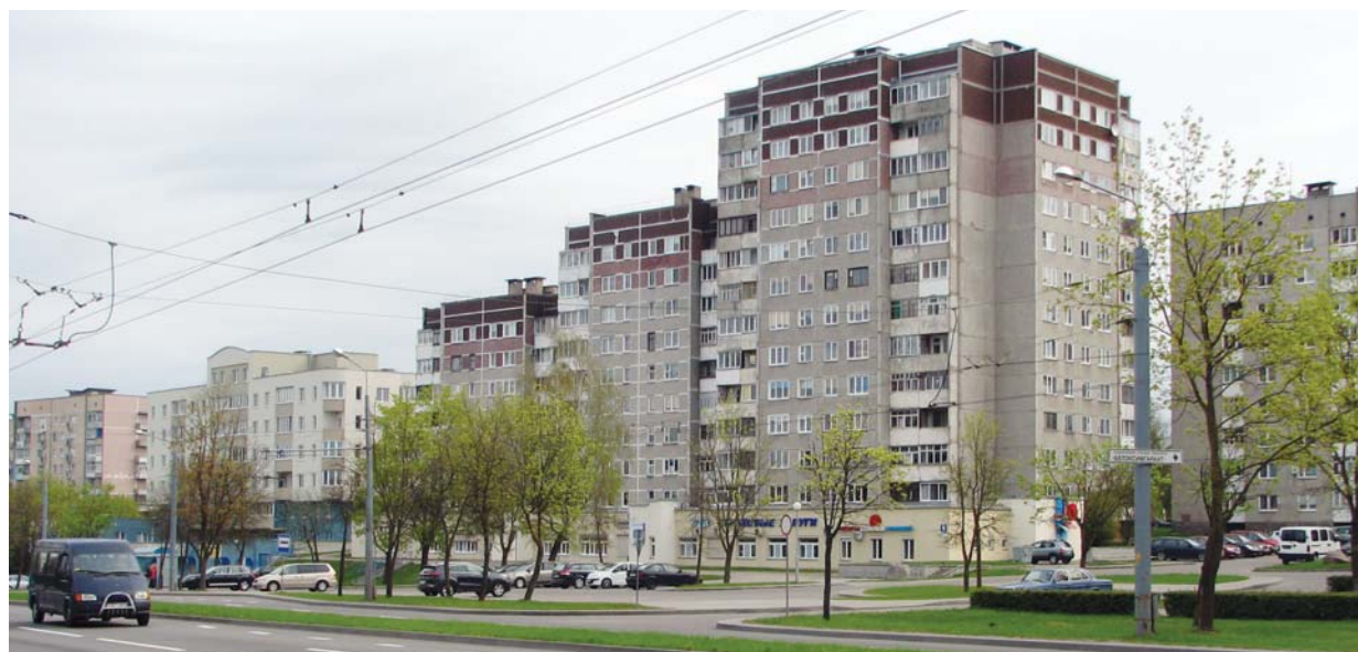
Дома 88-й серии 1990-х годов со стенами толщиной 300 мм
